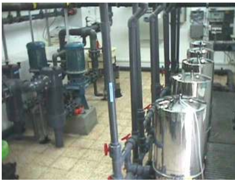
בריכה טיפולית שער הנגב – סוללת מסננים דיאטומיים מסוג עלים ( נתקבל סיוע של הקרן להקמה)
