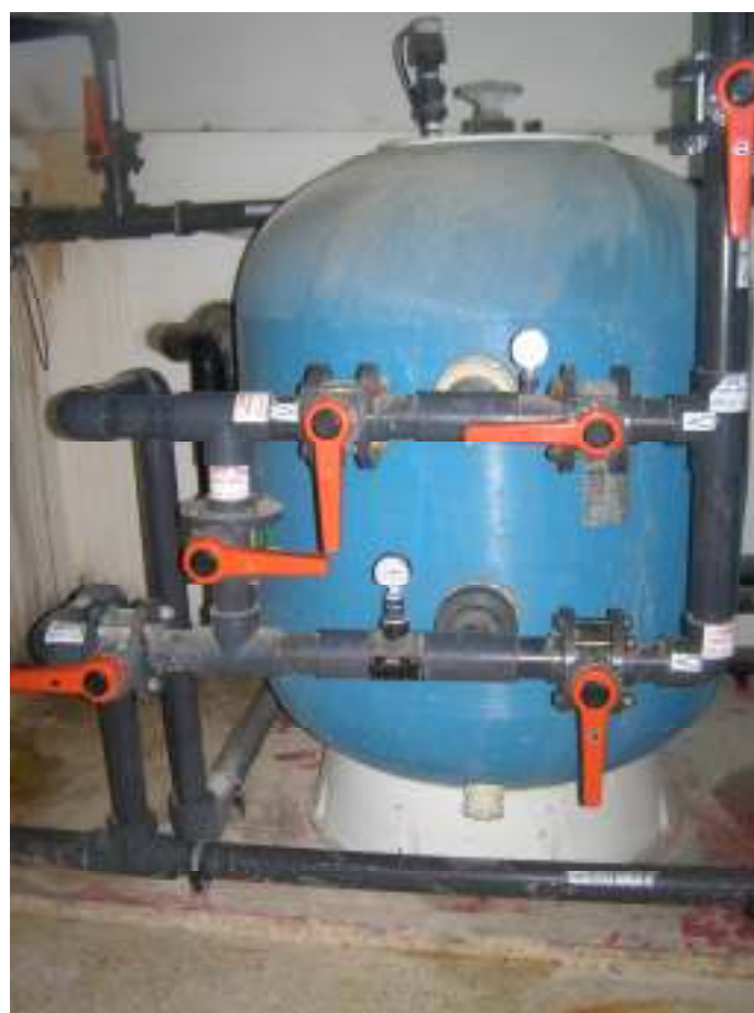
בריכה טיפולית איל"ן גילה ירושלים – מסנן גרנולרי ( נתקבל סיוע של הקרן להקמה והצטיידות)
